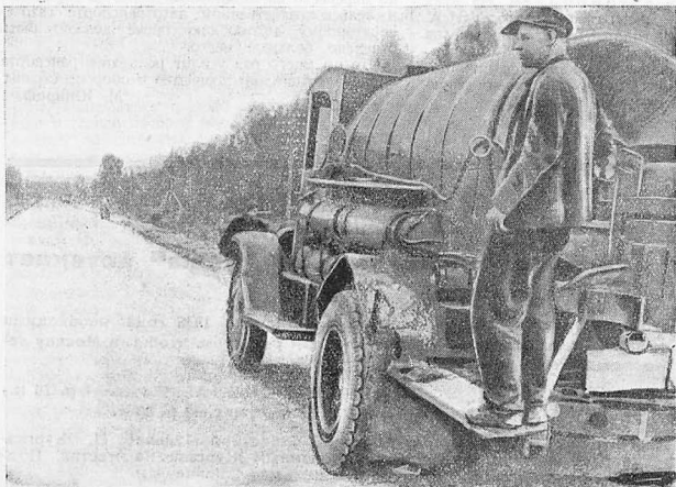
Гудронатор на строительстве Можайского шоссе
